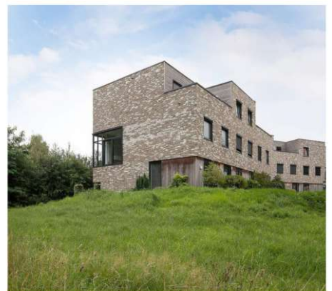
Collectieve woning als dorpsrandafwerking | Bosgaai, Eindhoven (NL) - Cie Architects
