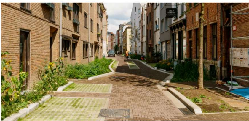
Ontmoetingsruimte, verkeersremmende maatregelen en vergroening via een kronkelend profiel van de weg Tuinstraten Antwerpen
