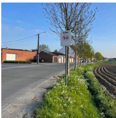
Te breed wegprofiel in de Vagevuurstraat bij het binnenrijden van de wijk moedigt te snel rijden aan
